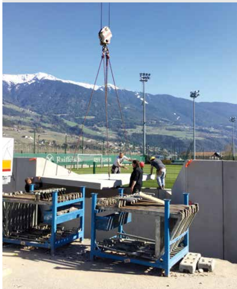
Montage der Betonfertigteile der Tribüne in der Sportzone Vahrn
