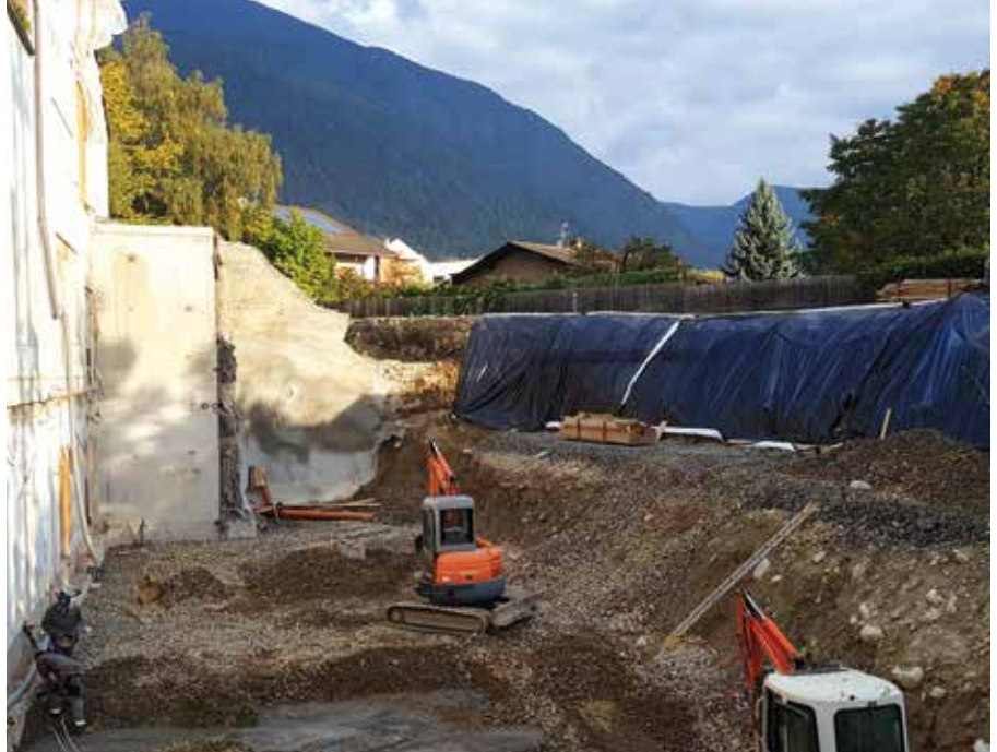
Baugrube für den neuen Kindergarten
